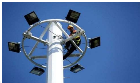
北京铁塔微站一体化 EPC总承包
